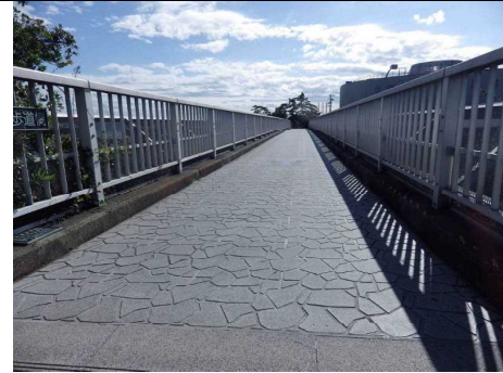
橋面 (A1側より撮影)
